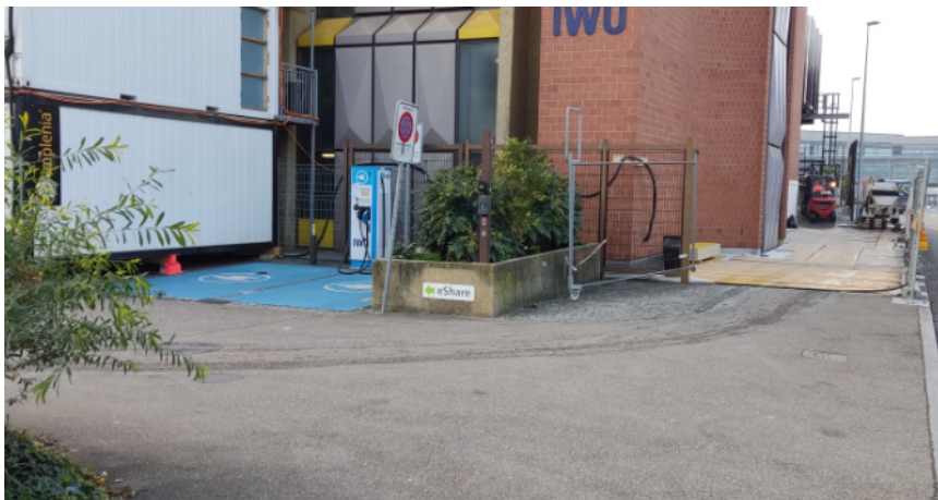
Heizwerk Bahnhof, Solothurnerstrasse 18, Basel
